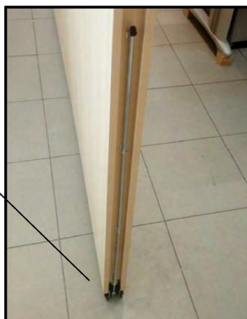
CASQUILLO DE FIJACIÓN PERFORADO EN PAVIMENTO
