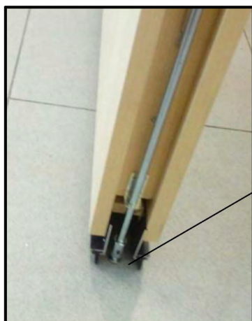
CASQUILLO DE FIJACIÓN PERFORADO EN PAVIMENTO
